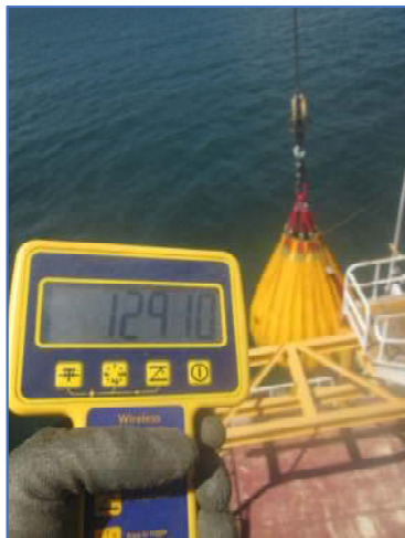
Radius : 10 m Angle : 69° Boom Length : 27.6 m (Main Hoist)
