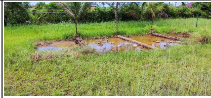
Pict 5. Area Pipe rack yang masih tidak terawat
