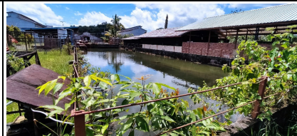
Pict 8. Water resource: Water treatment area yang terlalu jauh dengan area Pipe Yard: +/- 800 m
